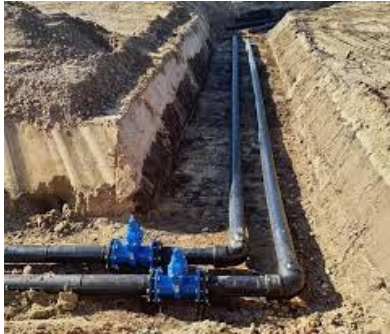
Foto van bronnet leidingen in constructie
